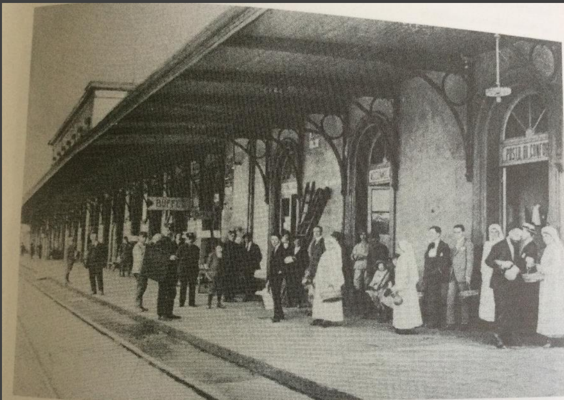
Stazione di Ferrara (ingresso Posto di Conforto)
