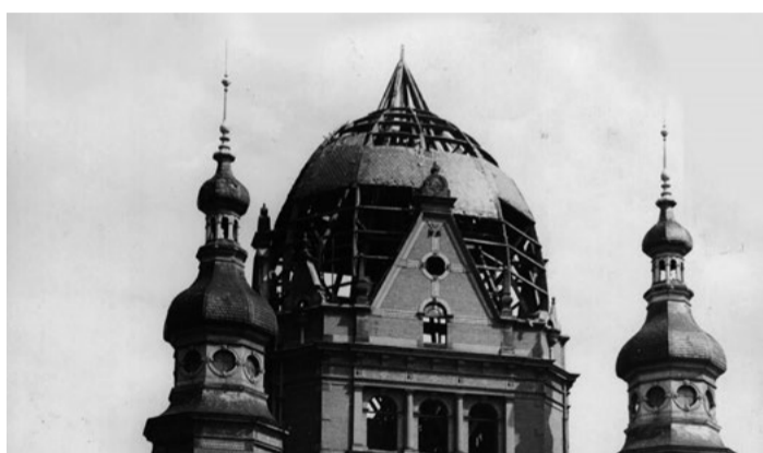
► Un particolare della sinagoga di Danzica dopo l'incendio
