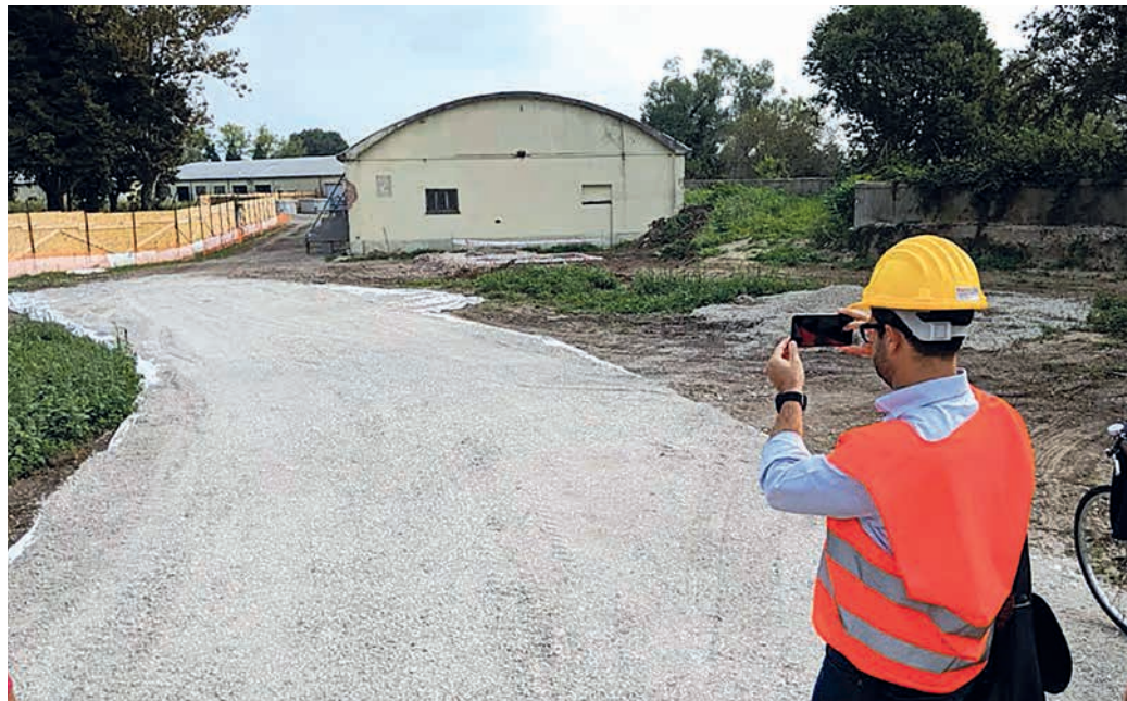
► Un sopralluogo nell'area dell'antico cimitero ebraico di Mantova, al centro del progetto di rigenerazione urbana Mantova Hub. Un percorso ricco di opportunità, ma anche di sfide
