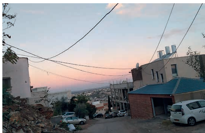
► Collegamenti abusivi all’elettricità in un villaggio arabo
