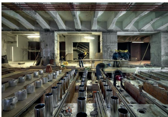
► I lavori di realizzazione del Memoriale iniziati nel 2010
