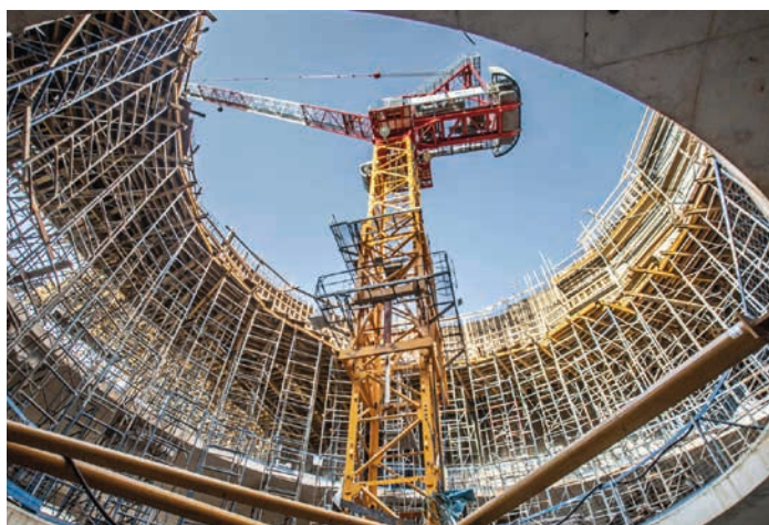
► I lavori per la realizzazione dei nuovi edifici della Biblioteca
