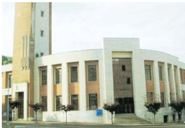
▲ Via Matteotti L'ex Casa del Fascio del paese che diede i natali a Mussolini
