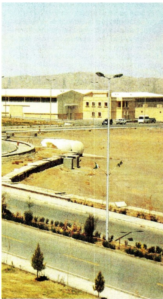
L'obiettivo. L'impianto di Natanz, a Sud di Teheran
